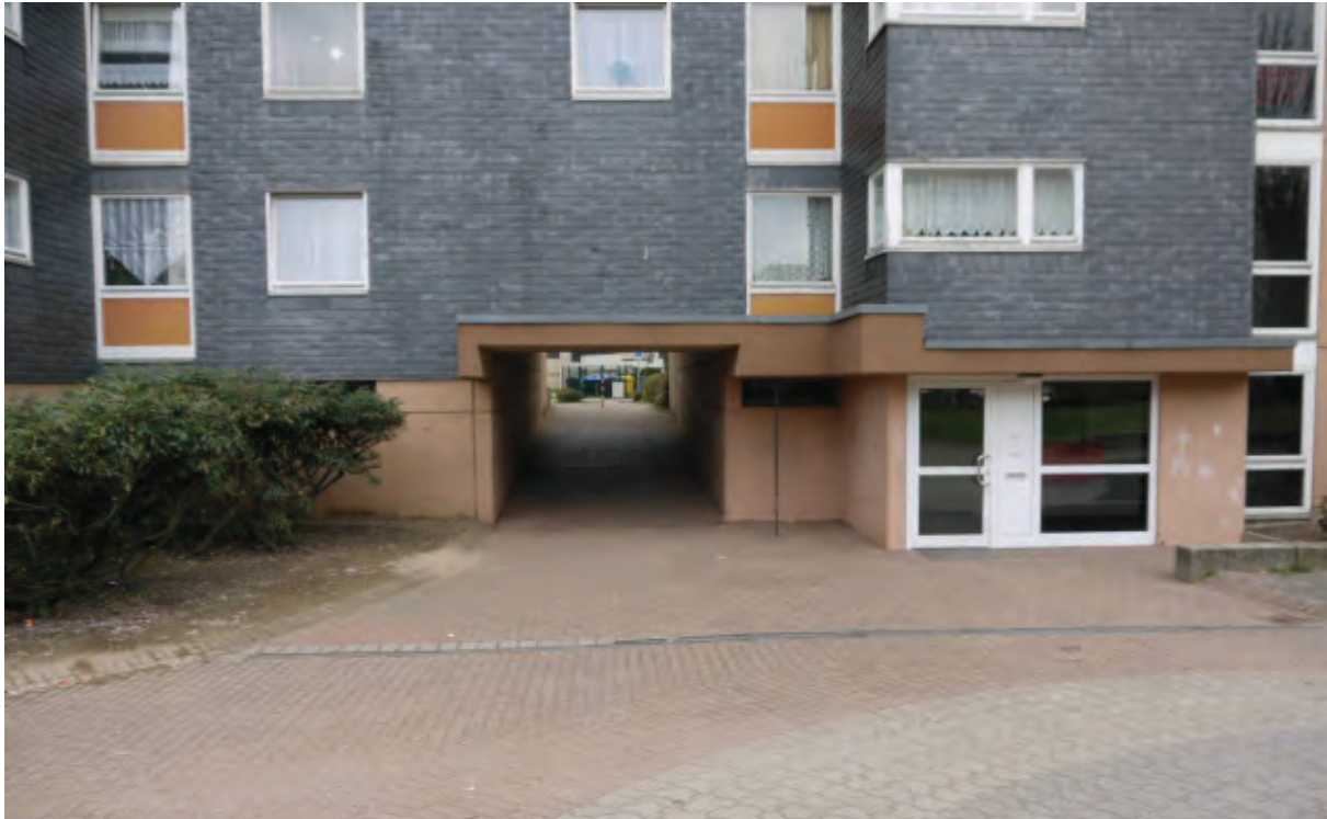
Abb. 67 Durchgang Block 8 Bestand
