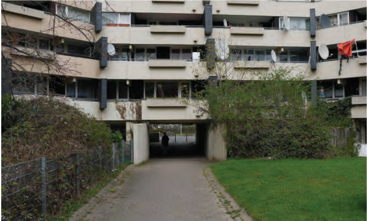
Abb. 65 Durchgang Block 9 Bestand
